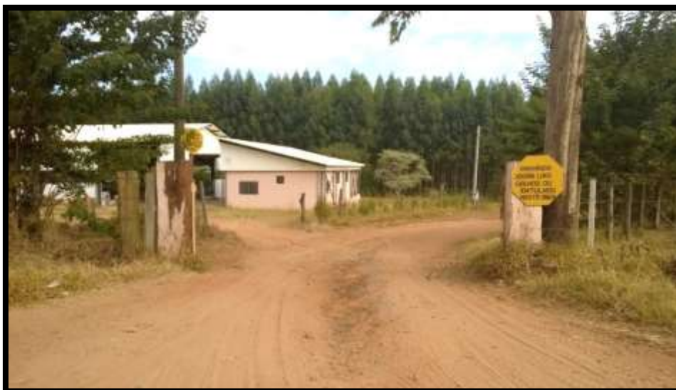
Figura 43 - Entrada do Centro de Triagem e Aterro em Valas
