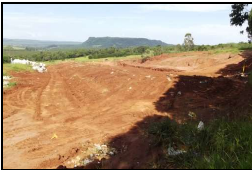
Figura 50 - Vista do Aterro em Valas – Itirapina-SP
