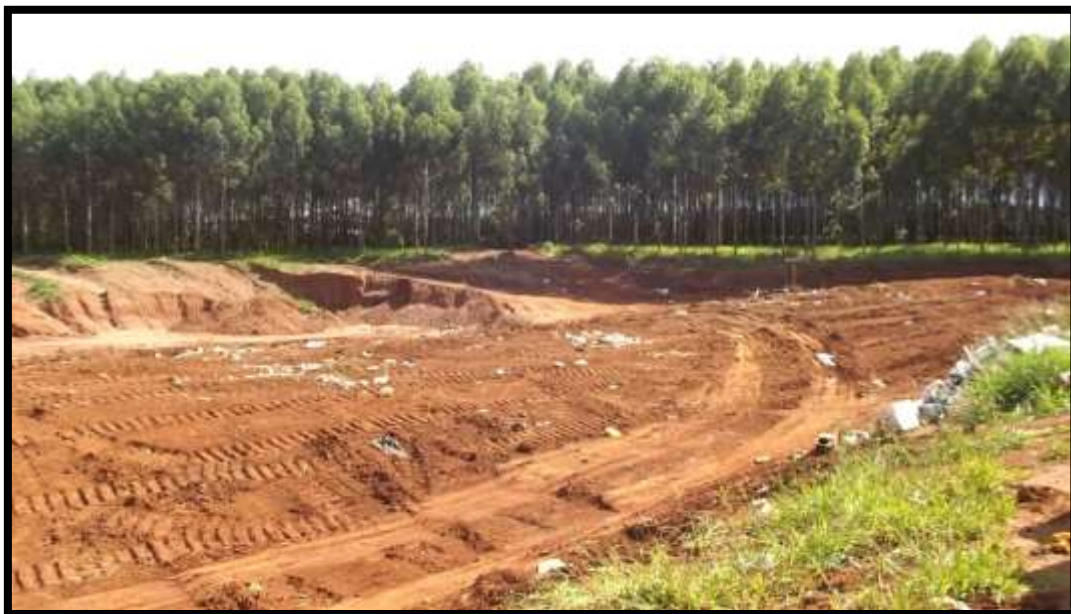
Figura 54 - Vista do Aterro em Valas - Itirapina-SP
