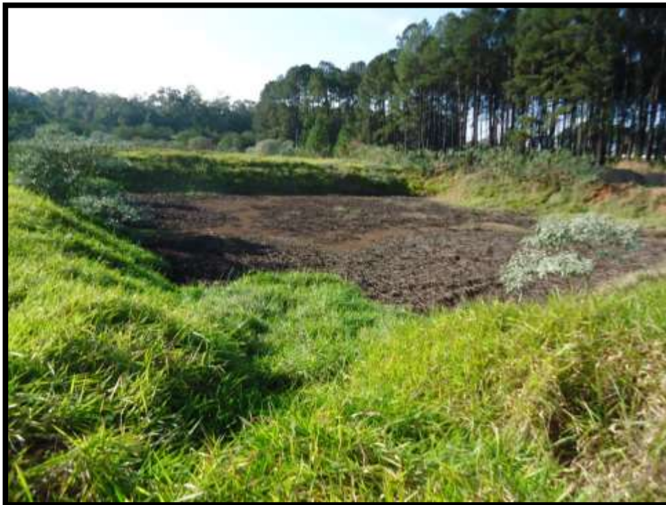
Figura 20 – Antiga ETE desativada.
