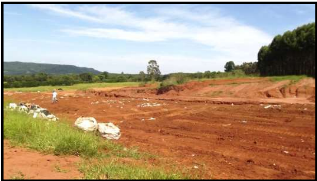
Figura 52 - Vista do Aterro em Valas – Itirapina-SP
