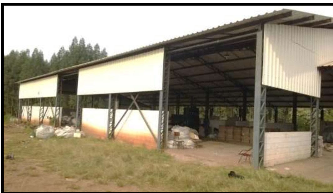
Figura 48 - Centro de Triagem Operado pela COOPEREI
