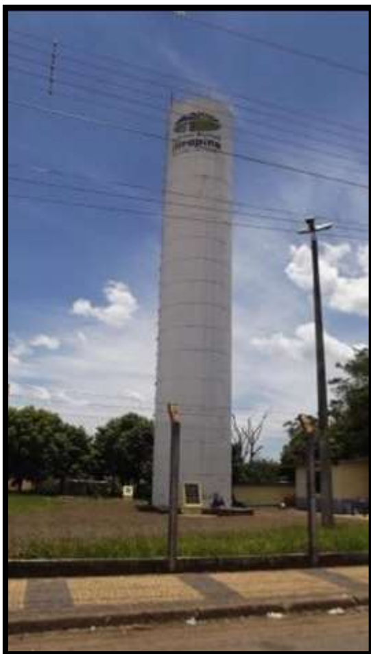
Figura 13 - Reservatório 04 - Rua 5 – Vila Garbi
