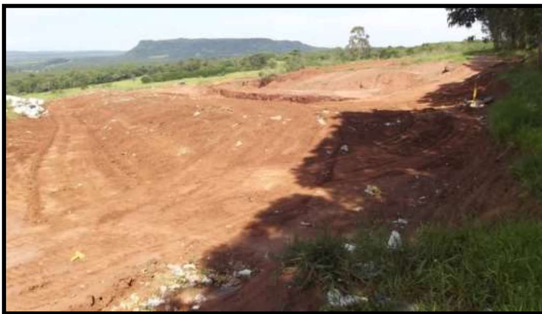
Figura 55 - Vista do Aterro em Valas - Itirapina-SP
