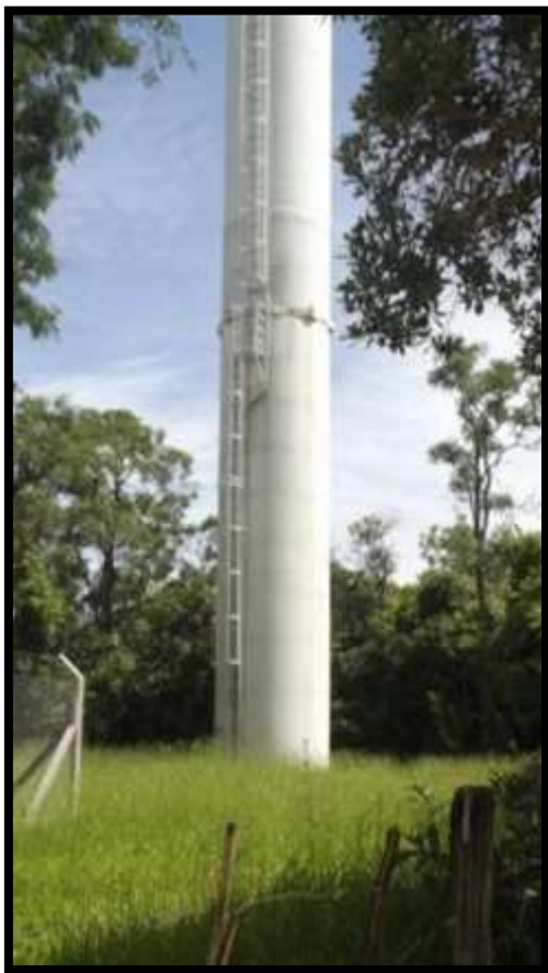
Figura 18 - Reservatório 09 - Rua 3, Estância Ubá
