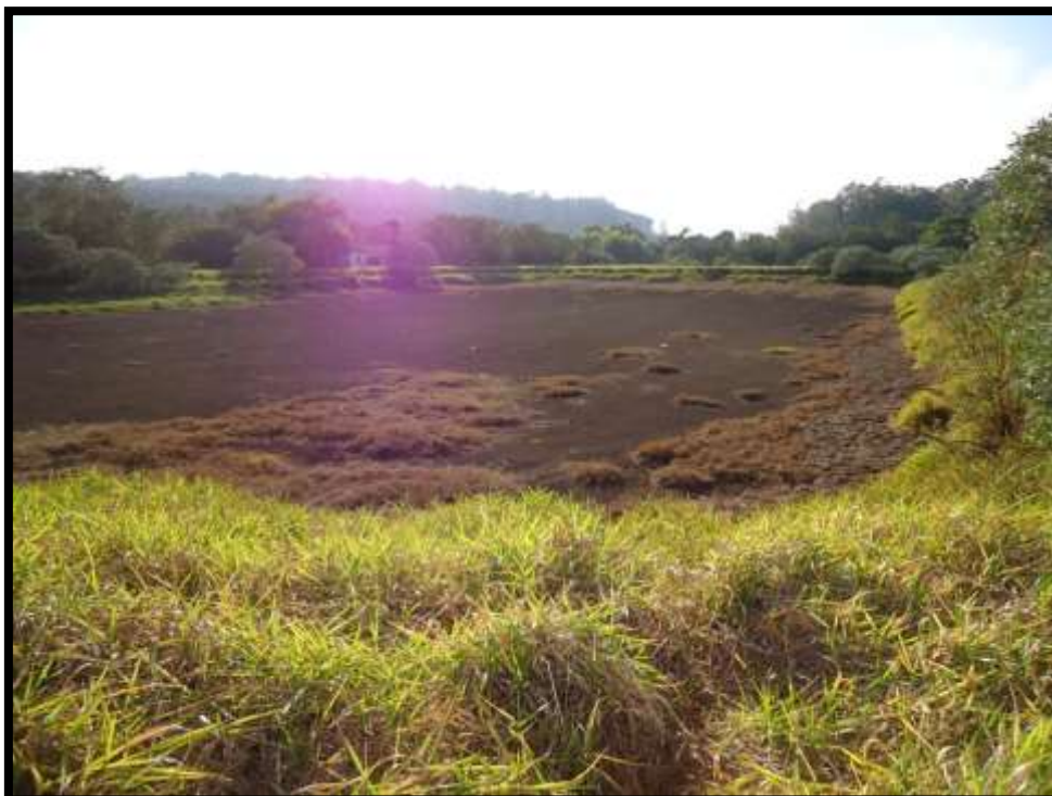
Figura 21 – Antiga ETE desativada.
