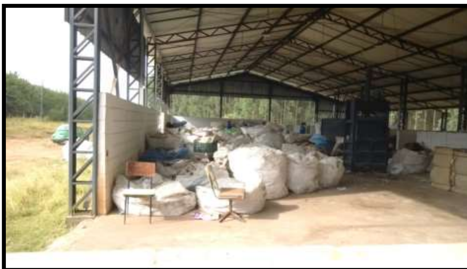
Figura 44 - Centro de Triagem Operado pela COOPEREI
