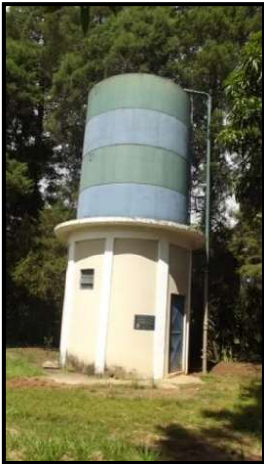
Figura 17 - Reservatório 7 Jardim Ubá –Itirapina-SP
