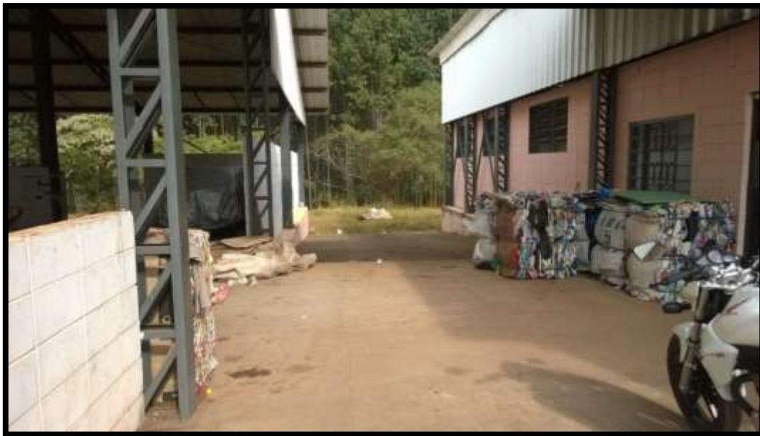
Figura 46 - Centro de Triagem Operado pela COOPEREI
