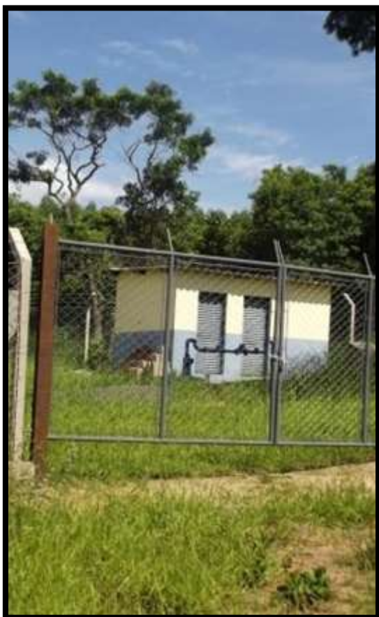
Figura 9 - Poço 08 - Rua 3, Estância Ubá
