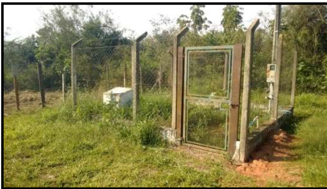
Figura 32 - Vista do local da Estação Elevatória de Esgoto 02 - Jardim Nova Itirapina
