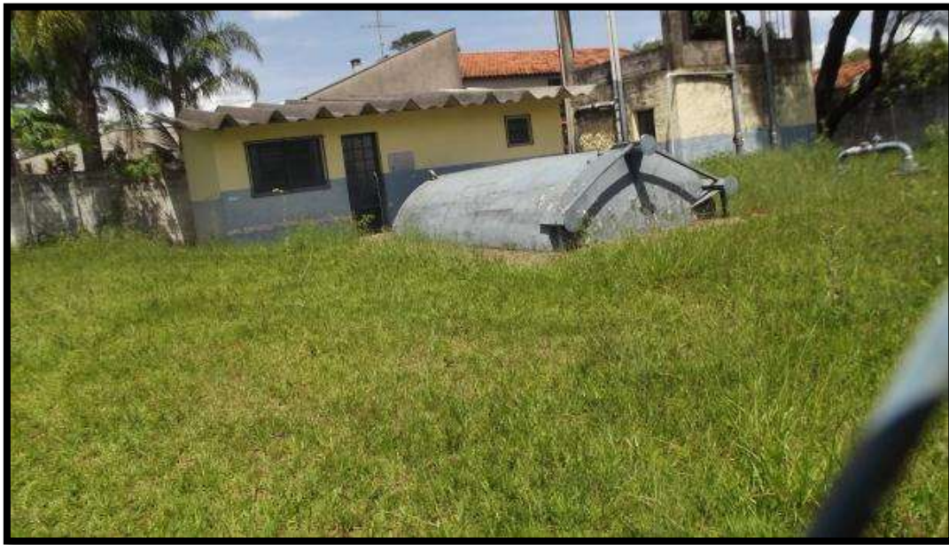
Figura 6 - Poço 05 - Rua 13, Balneário Santo Antônio
