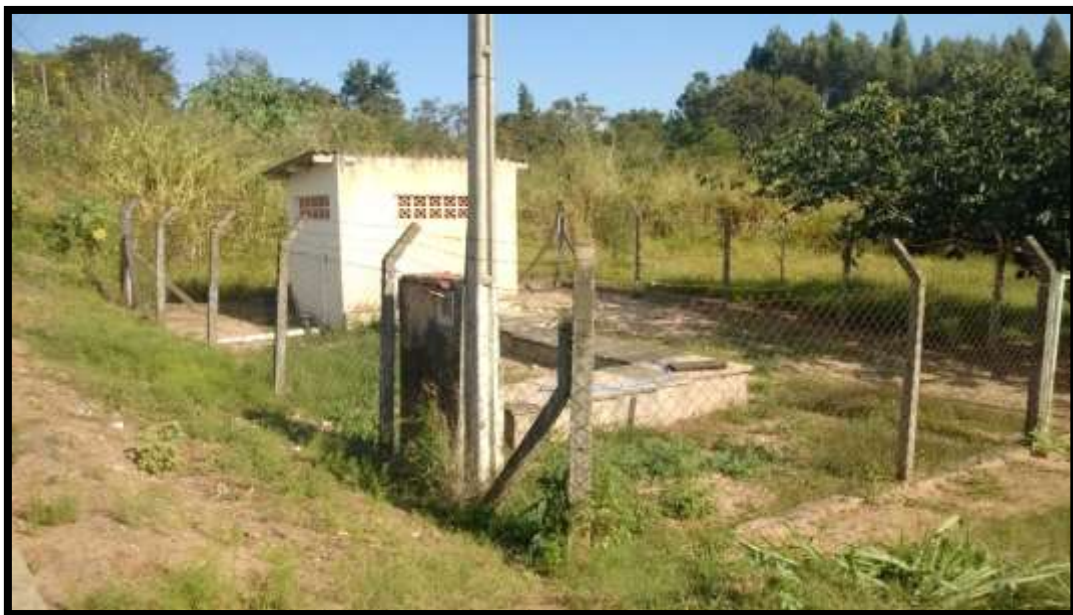
Figura 31 - Estação Elevatória de Esgoto 01 - Jardim Lemos
