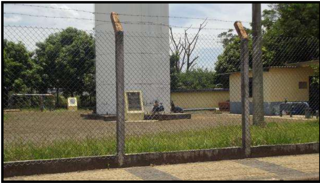
Figura 4 - Poço 02 e Reservatório 4 e Poço 01– Rua 5- Vila Garbi
