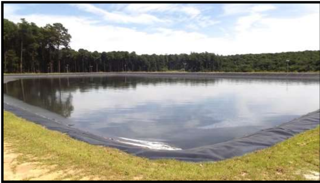
Figura 26 - Lagoa anaeróbia
