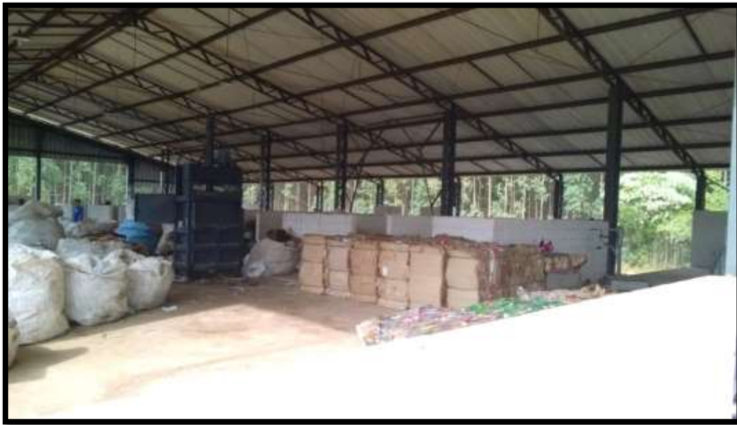
Figura 45 - Centro de Triagem Operado pela COOPEREI
