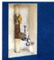
Registro de latão diâmetro 3/4" com Torneira de Jardim (instalar logo na saída da Caixa de Proteção)
