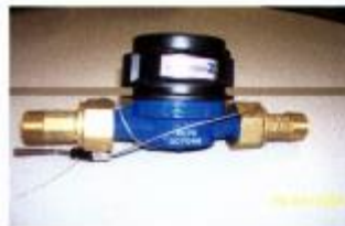
Hidrômetro padrão, conexões (porca e tubete) e lacre anti-fraude
