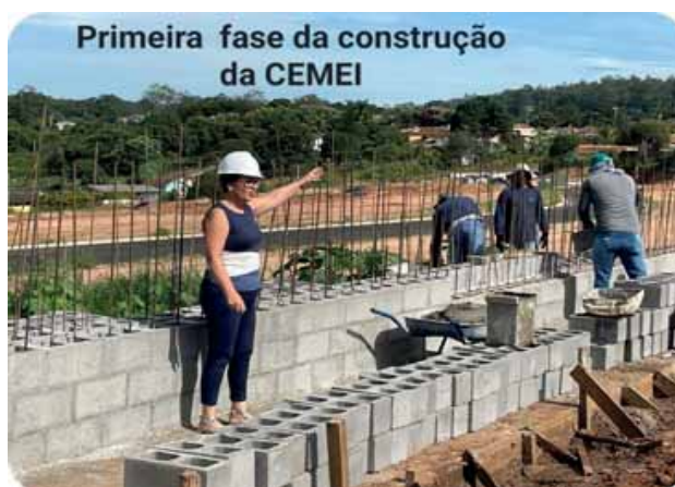
Imagem 16: Construção do CEMEI
